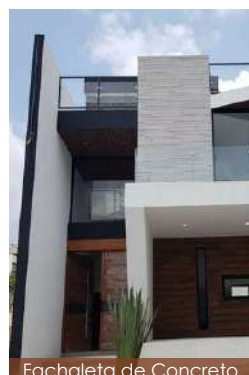
Fachaleta de Concreto
