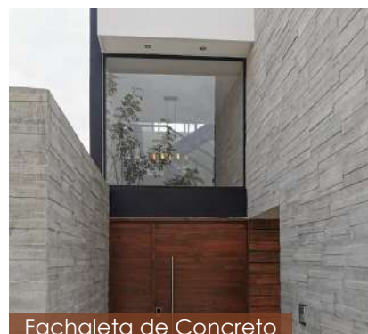
Fachaleta de Concreto
