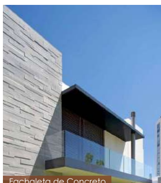
Fachaleta de Concreto
